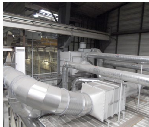
Die Rückführung der gereinigten Luft lässt sich stufenlos regeln.
