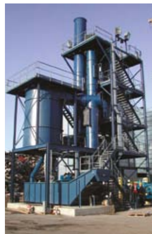
Shredderanlagen zerkleinern große Mengen alter Autos, Haushalts- und Elektrogeräte um die Rohstoffe anschließend nach Sorten getrennt einer Wiederverwertung zuzuführen.
