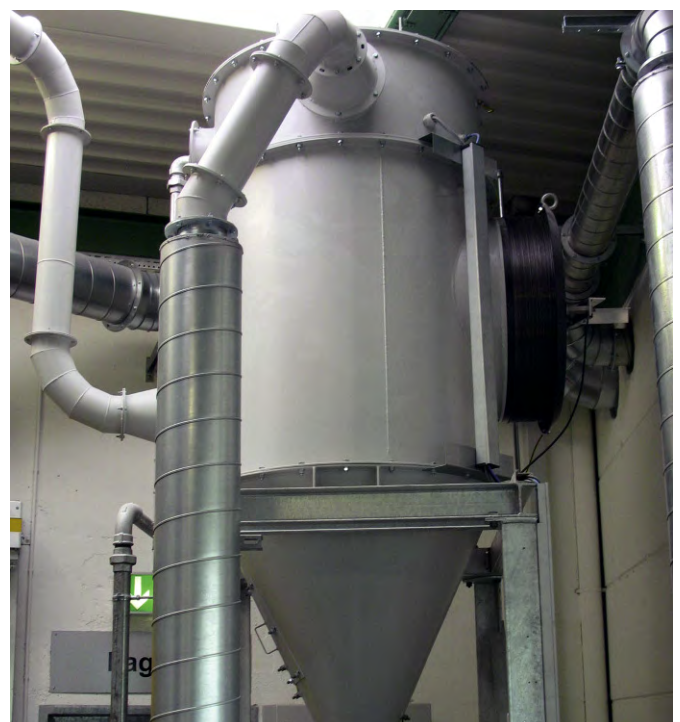
Filter mit flammloser Druckentlastung (Totalabscheider)
