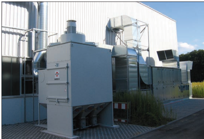
VARIO 5 eco mit Funkenvorabscheider und Wärmerückgewinnungsanlage
