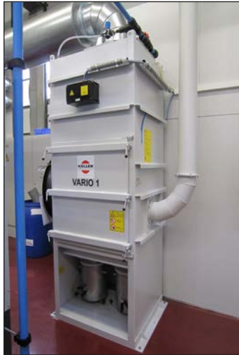
VARIO 1 eco als Zentrale Vakuumsauganlage
