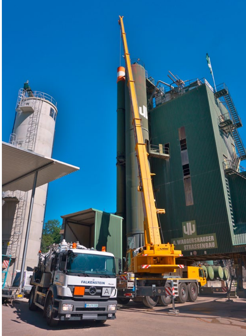
Mit dem Autokran ließen die Experten eine rotierende Reinigungsdüse im Kamin auf und absteigen. Mit einem Wasserdruck von 1.000 bar löste das Reinigungswerkzeug die Beläge von den Wänden.
